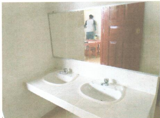
Toma N° 03: LAVATORIOS Y ESPEJO EN PARED EN SS.HH.
