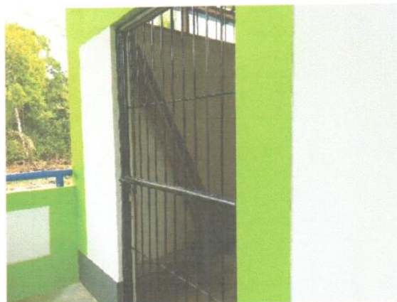
Toma N° 15: PUERTA DE FIERRO EN CASA DE FUERZA.
