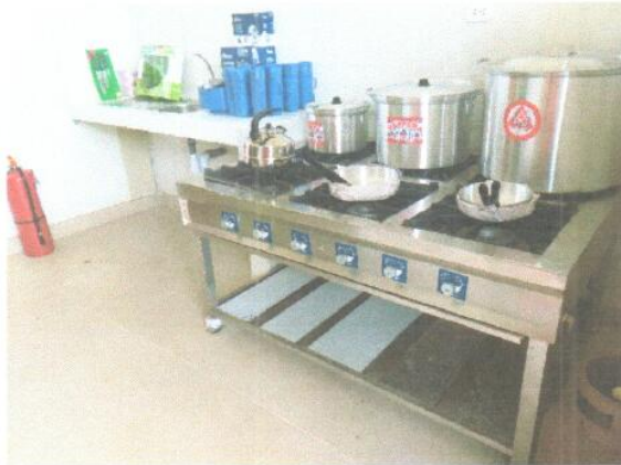
Toma N° 09: COCINA INDUSTRIAL, JUEGO DE OLLAS, SARTENES EXTINTOR Y BALON DE GAS EN MODULO COCINA.
